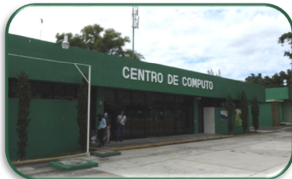
Centro de Cómputo
